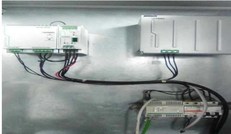
Figura 19: Funcionamiento del Gateway EGX 300
