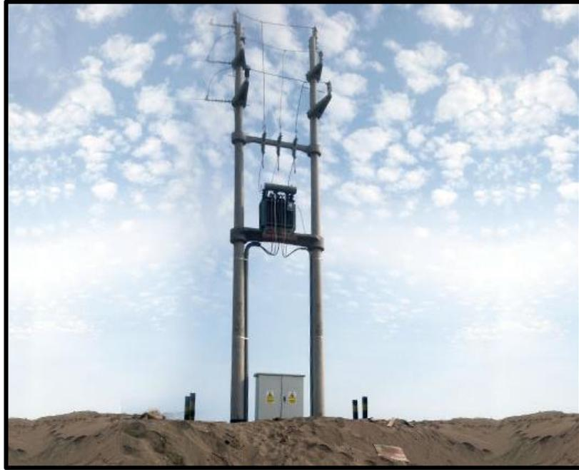
*Figura N° 2 Subestación Aérea Biposte*
