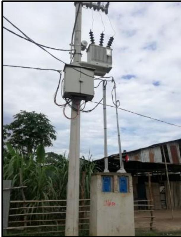
*Figura N° 1 Subestación Aérea Monoposte*
