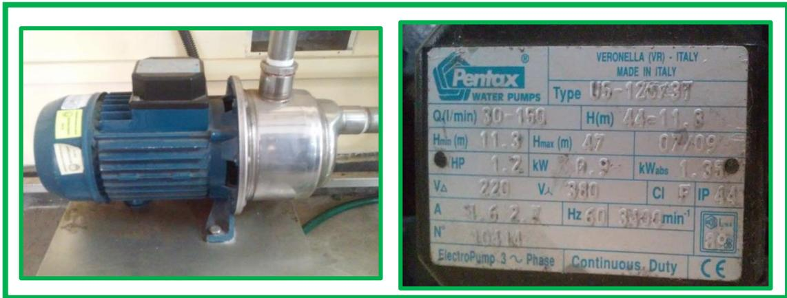
FIGURA N° 16: BOMBA ELÉCTRICA Y DATOS DE PLACA
