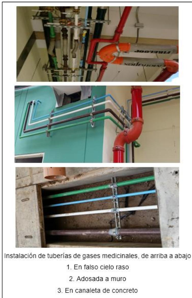
**Figura 16. Tipos de instalación de tuberías de gases medicinales**
