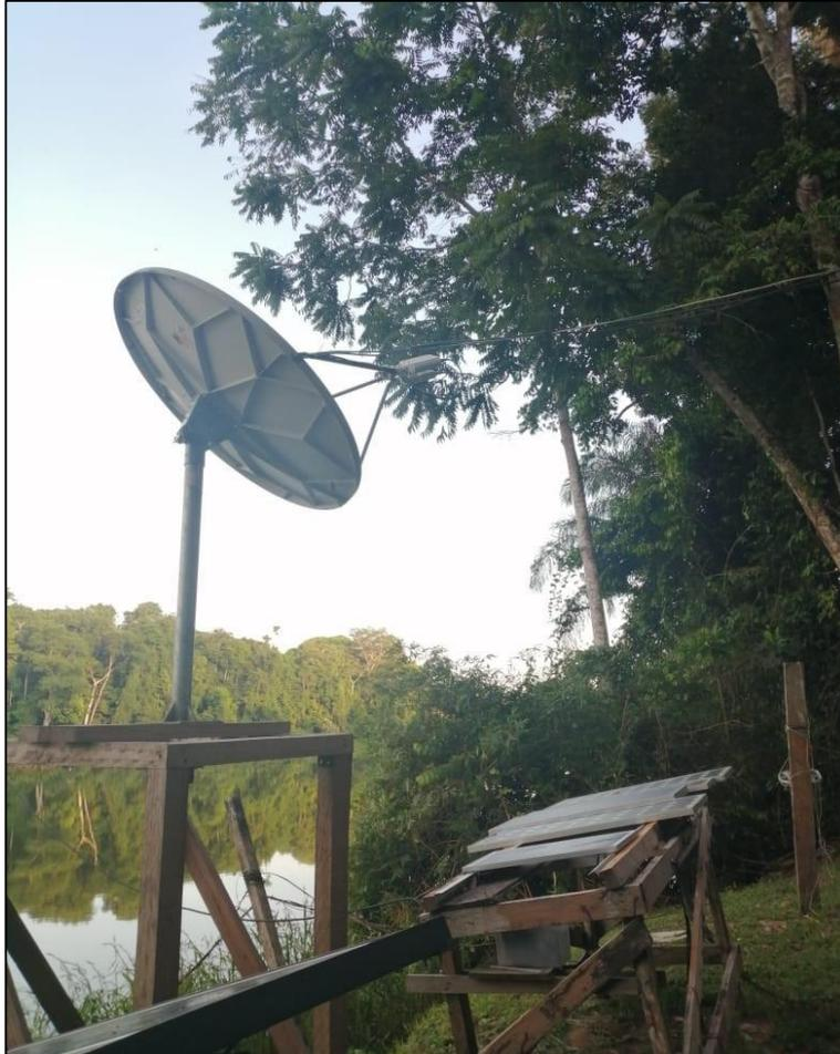
Figura 20:Antena satelital Vsat de la estación biológica.
