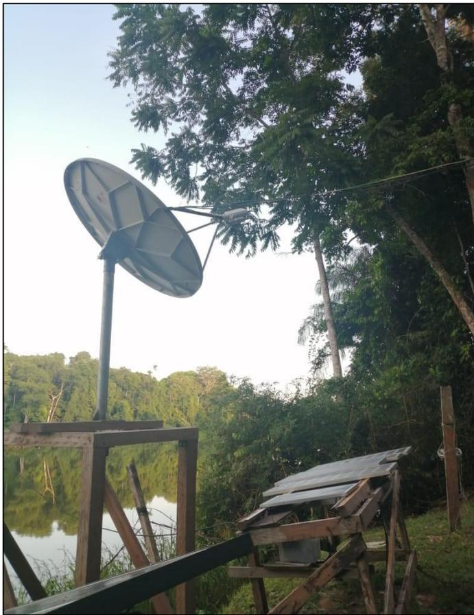
Figura 65: Antena VSAT apuntada hacia el satélite TELSTAR19V.
