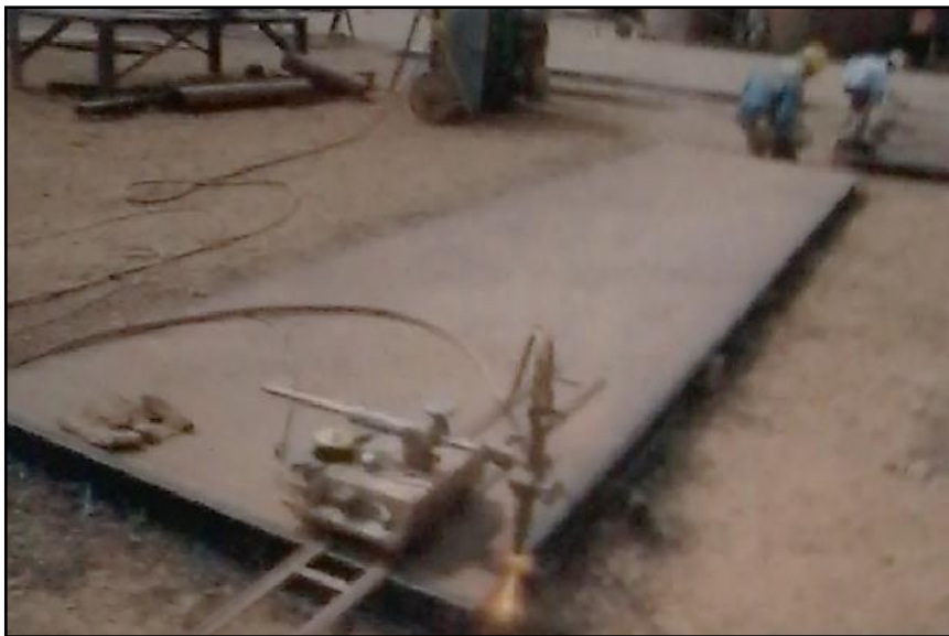
Figura 3.11 Corte con Oxigeno.
