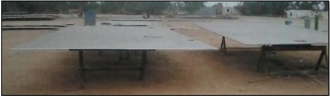
Figura 3.12 Planchas esmeriladas y aprobadas para el rolado.
