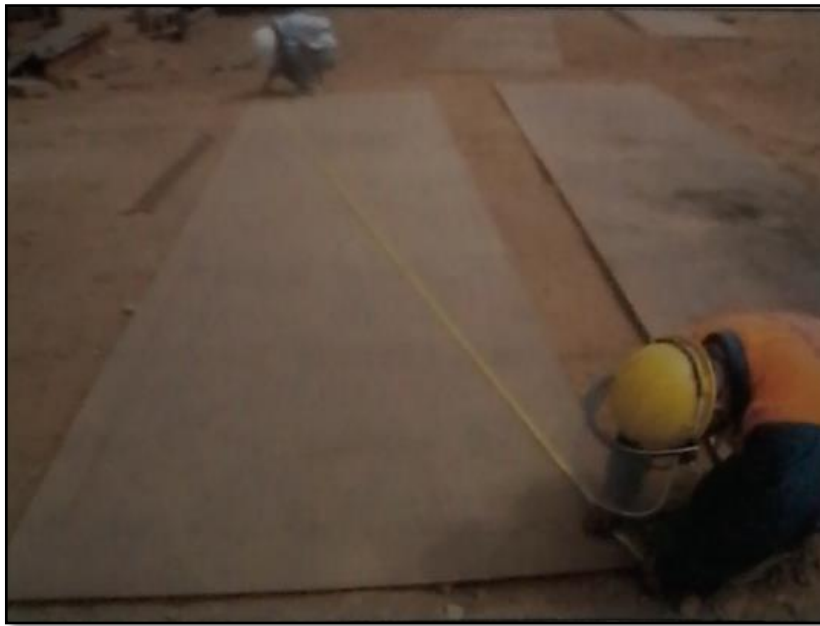
Figura 3.10 Control Dimensional de Planchas.
