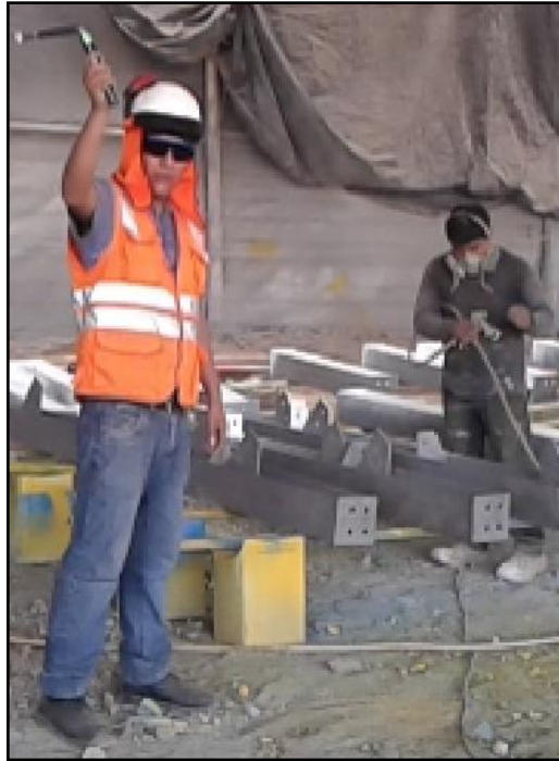
Figura 3.23 Medición de la Humedad relativa con Psicrómetro, al momento de la aplicación.
