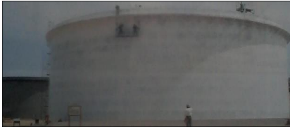
Figura 3.27 Pintado de tanque.
