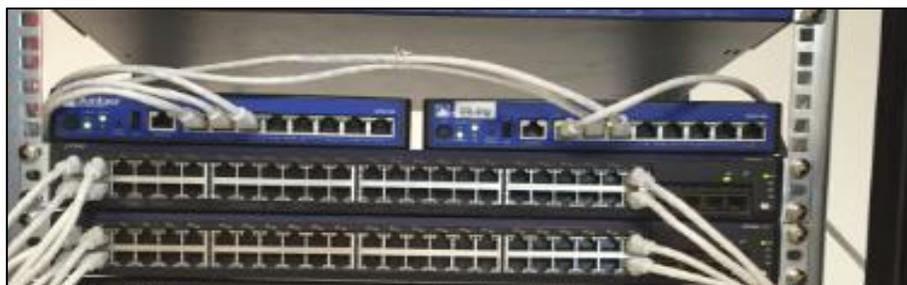
**Figura 3.54.- Equipo configurado como switch de acceso y sus conexiones en el equipo juniper. Elaboración propia**
