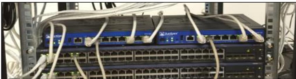
**Figura 3.53.- Equipo switch configurado como equipo principal. Elaboración propia**
